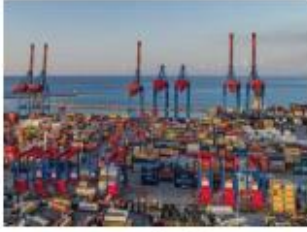
الصورة (٣) مرفأ تجاري
